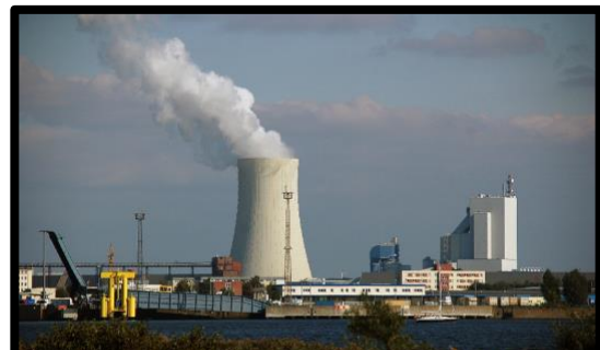
Das Kohlekraftwerk Rostock Foto: Ra Boe, Wikipedia
